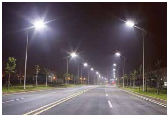
Слишком высокий индекс цветопередачи – светильники ослепляют водителей
