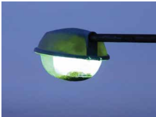
Загрязненный поликарбонатный защитный колпак снижает освещенность
